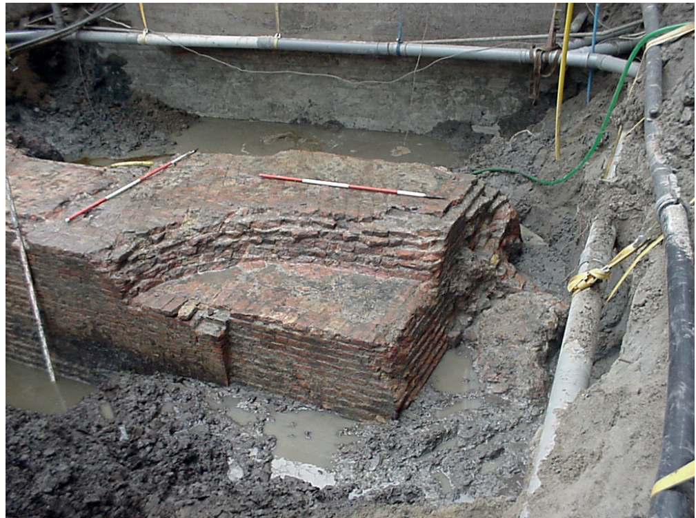
Afbeelding 11. Restanten van de fundering van de zuidgevel van de hoofdburcht, gevonden tijdens de waarneming in 2001.
