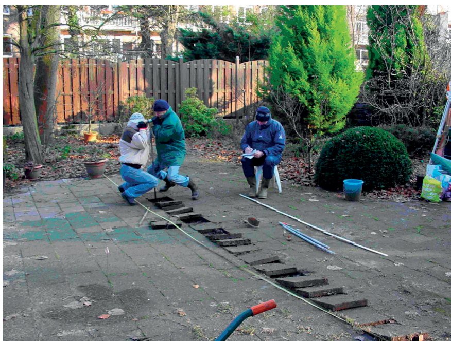
Afbeelding 14. Uitvoering van het booronderzoek in deelgebied 2 Foto: J. Eijsackers
